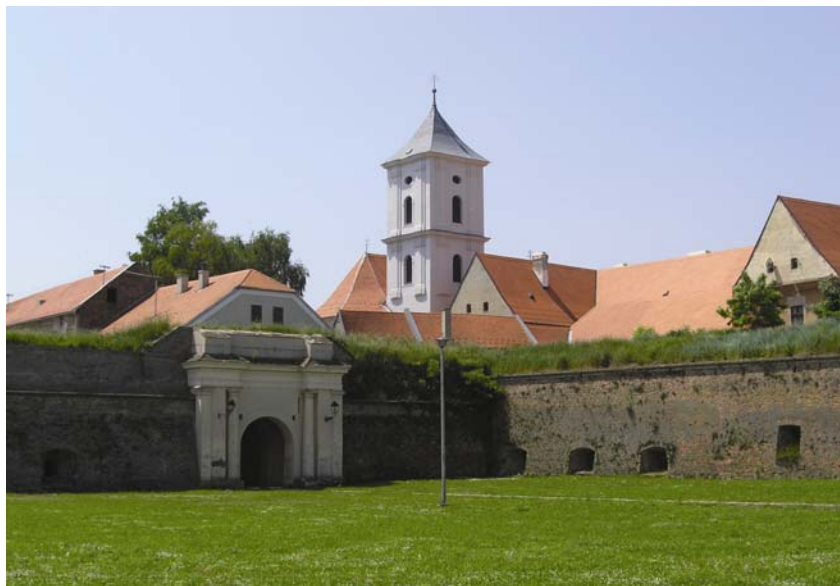
Pogled na vodena vrata
